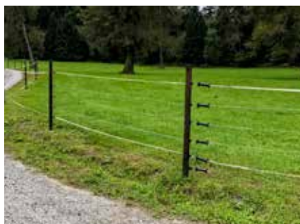
Litzen- und Drahtzäune mit mindestens 5 gut gespannten Litzen auf Holz- oder Metallpfosten und einer Höhe von 110 cm Fixzaun. Die stromführende unterstes Litze hat den idealen 20 cm Bodenabstand.
