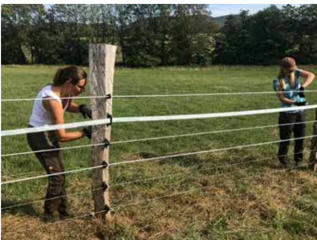
Fixzaun auf Pferdekoppel und Rinderkoppel mit verschiedenen Litzen zur Wolfsabwehr
