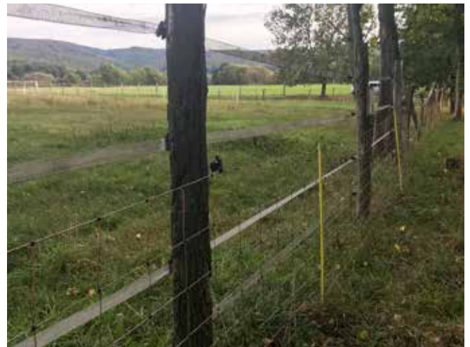
Ein bestehender Fixzaun wurde zusätzlich von außen gesichert.
