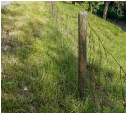
Eingewachsene Knotengitter ohne Unterwühlenschutz und zu niedriger Zaunhöhe
