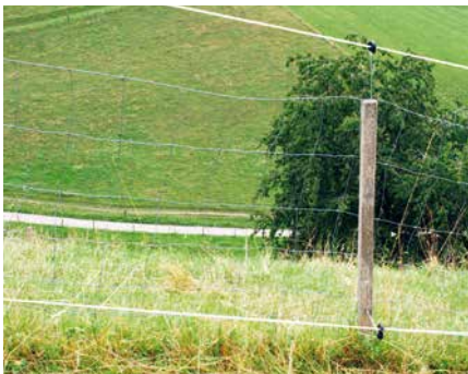
Knotengitter sind mit zusätzlichen Litzen verstärkt und in richtiger Höhe und Tiefe angebracht, nämlich 20 cm über dem Boden und in ca. 110 cm Höhe.
