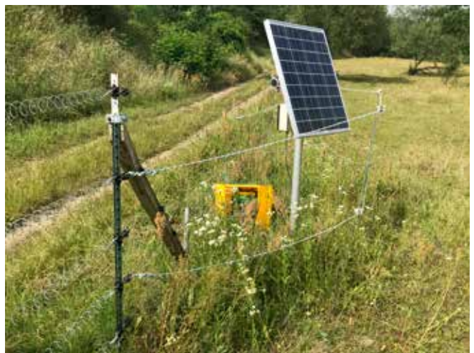
Stromversorgung mit Solargerät ist möglich
